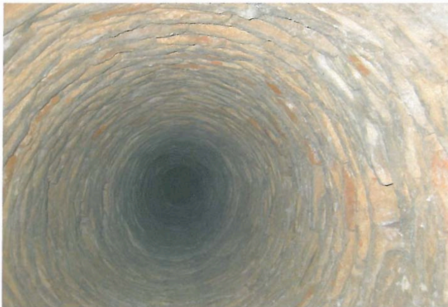
Fig. 5. la galería principal de transporte, de amplias dimensiones, conduce las aguas de manera independientemente en función de su calidad: las más duras por la canaleta izquierda y las más blandas por la de la derecha. A la dcha, fig. 6. los pozos de aireación, espaciados regularmente a lo largo de los galerías, que servían para acceder o lo zona de trabajo y la extracción de materiales al exterior, están revestidos de piedra o ladrillo hábilmente labrados.
