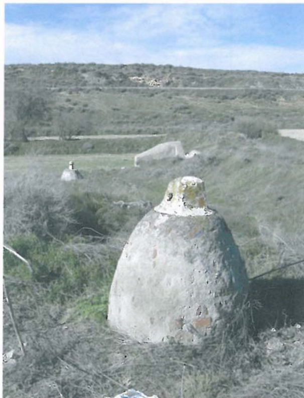
Fig. 7. El remate exterior de los pozos de aireación es una especie de capirote, con varios taladros en su extremo, que sirven como respiraderos, se denominan localmente "madamas". En Madrid se llaman "capirotos".
