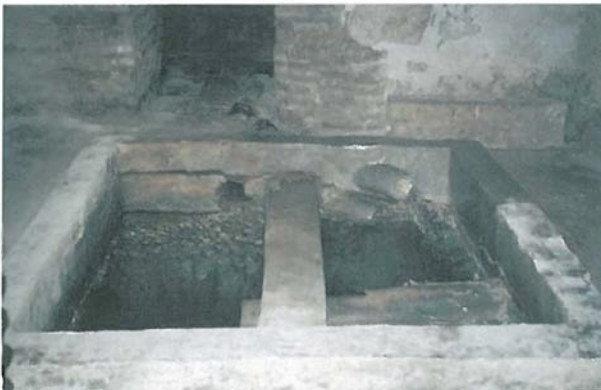
Fig. 9. la cámara de Isabel la Católica, de grandes dimensiones y bella arquitectura, es la estancia fundamental del viaje. Contiene una arqueta de reparto a la que llegan las aguas de las diferentes galerías, comunicándose con el exterior por una escalera en ladrillo de estilo mudéjar.
