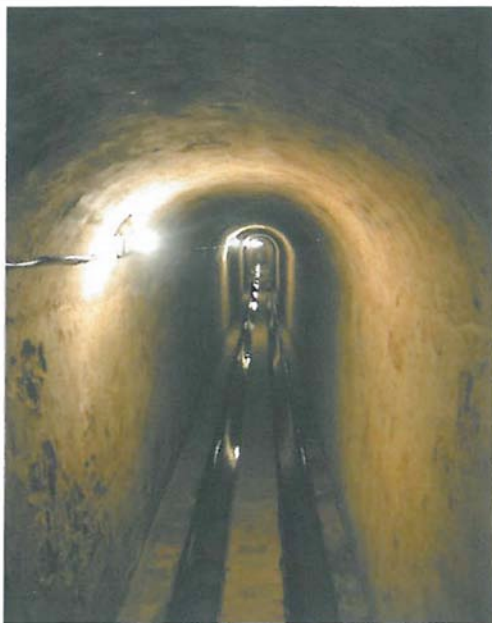
Fig. 5. la galería principal de transporte, de amplias dimensiones, conduce las aguas de manera independientemente en función de su calidad: las más duras por la canaleta izquierda y las más blandas por la de la derecha. A la dcha, fig. 6. los pozos de aireación, espaciados regularmente a lo largo de los galerías, que servían para acceder o lo zona de trabajo y la extracción de materiales al exterior, están revestidos de piedra o ladrillo hábilmente labrados.
